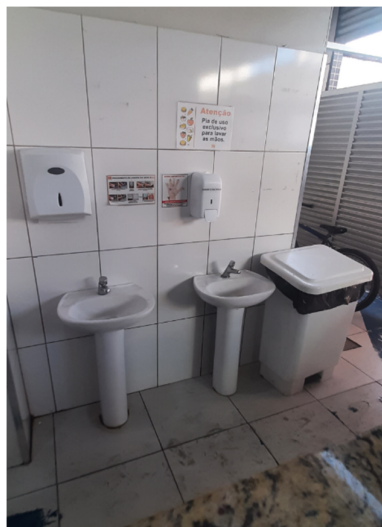
Lavatórios na saída dos banheiros dos usuários
